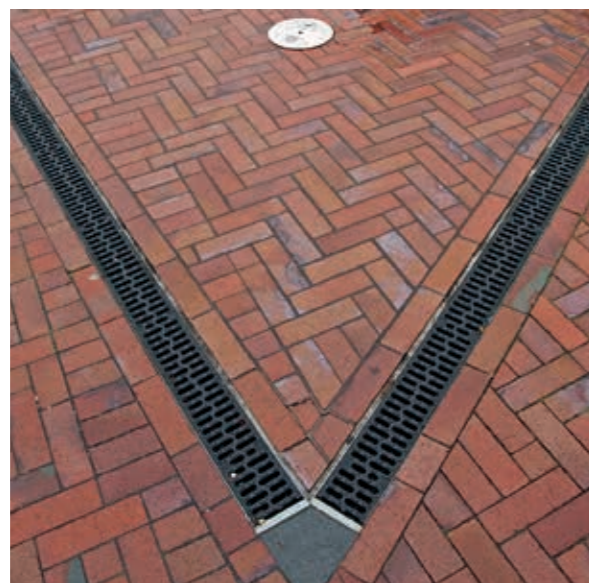
Abschlussdetail – Entwässerungsrinne, Barsinghausen, Deutschland
