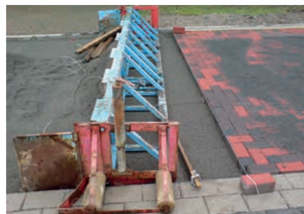
Abb. 5-10: Abziehen der Oberfläche der Bettung unter Verwendung der Lehre
