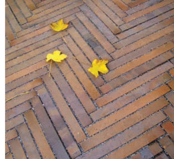
Pflasterklinker als Langformat verlegt im Fischgrätverband
