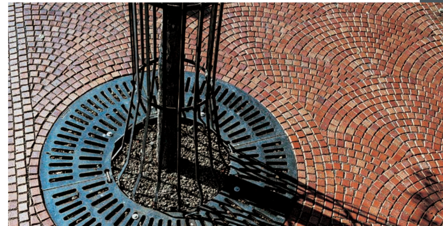
Einfassung von Einbauten mit Mosaikklinkern (Segmentbogenpflaster)
