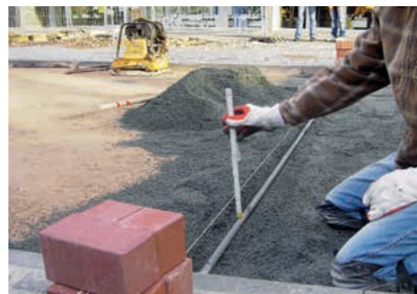
Abb. 5-9: Abziehen der Oberfläche der Bettung unter Verwendung von zuvor ausgerichteten Metallschienen
