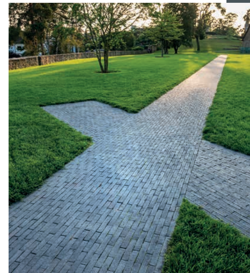
Parkweg mit Pflasterklinker, verlegt im Läuferverband in Gehrichtung, Kloster Lorsch
