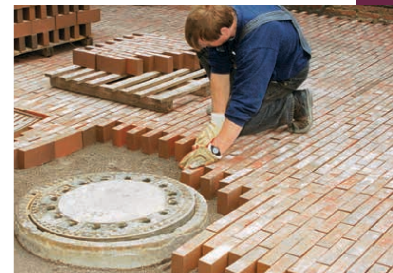
Anpassen von Pflasterklinker an Schachtdeckel und Einläufe (Einbauten)
