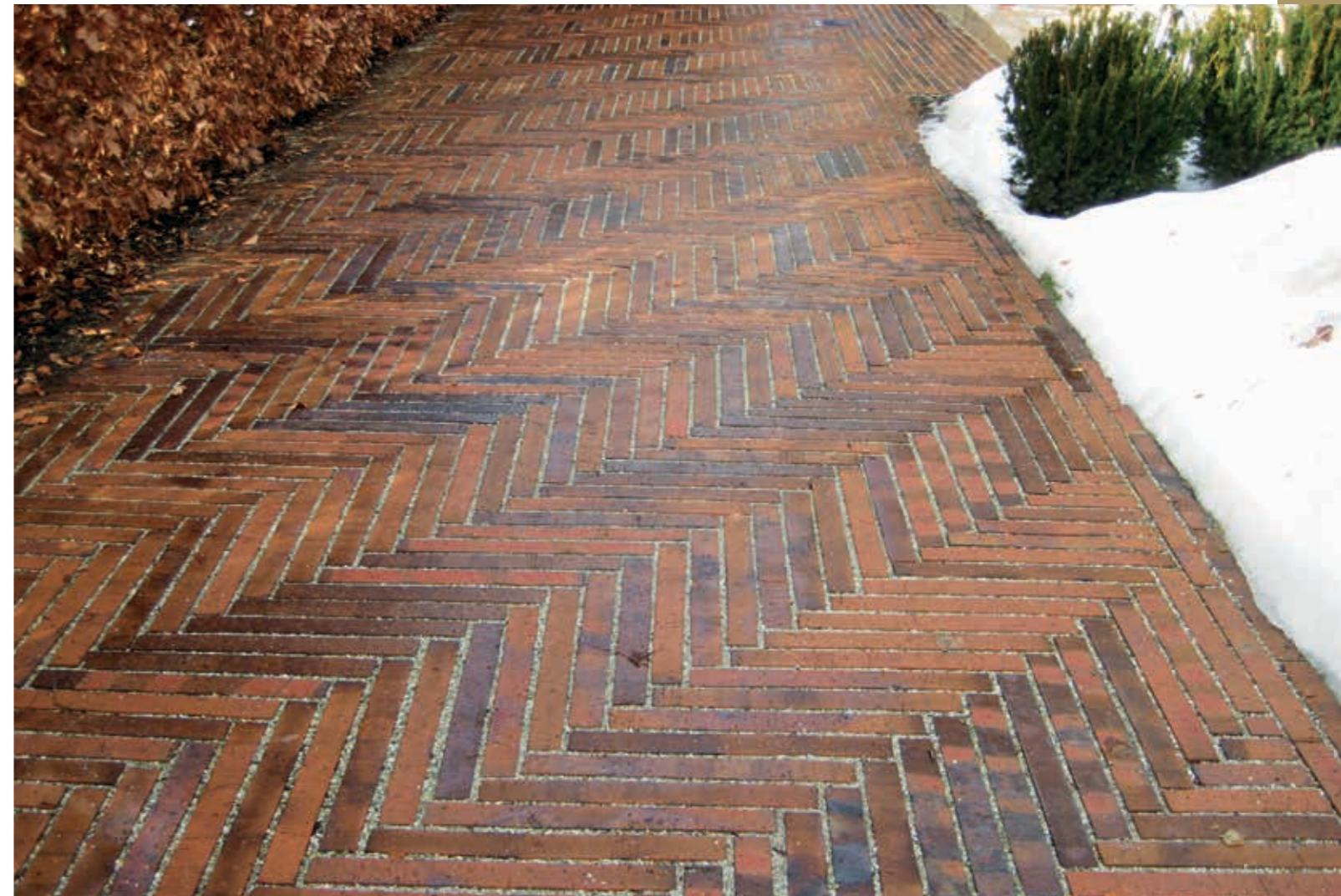
Hauseingang, Freising, Deutschland
